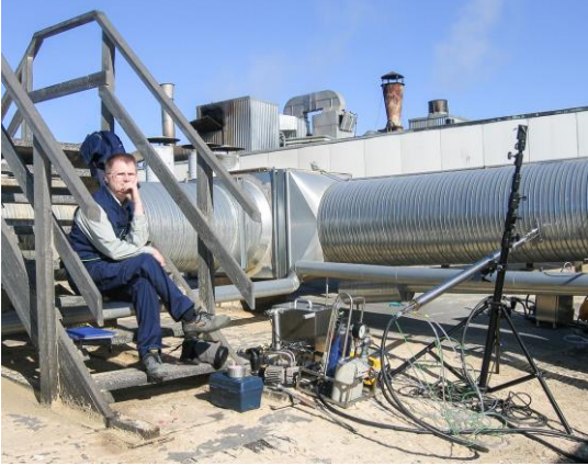
Timo tekemässä kanavamittauksia teollisuuslaitoksen katolla
